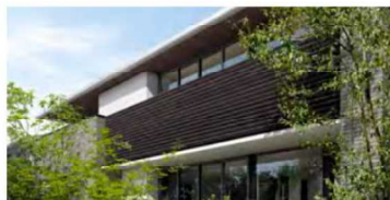
通風・採光を確保し美しい陰影を描く、木調ルーバー手摺
